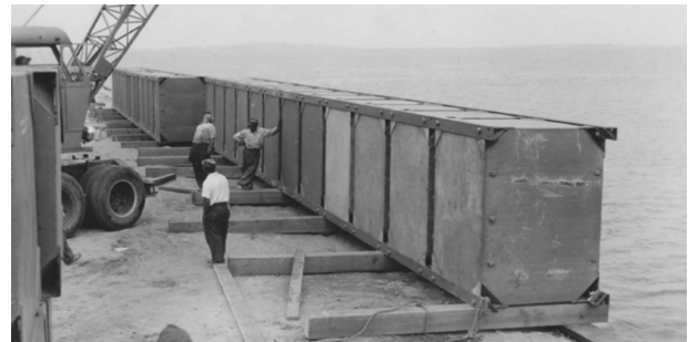
Рис. 5. З'єднані кутником стрингером модулі-понтони типу NLP
