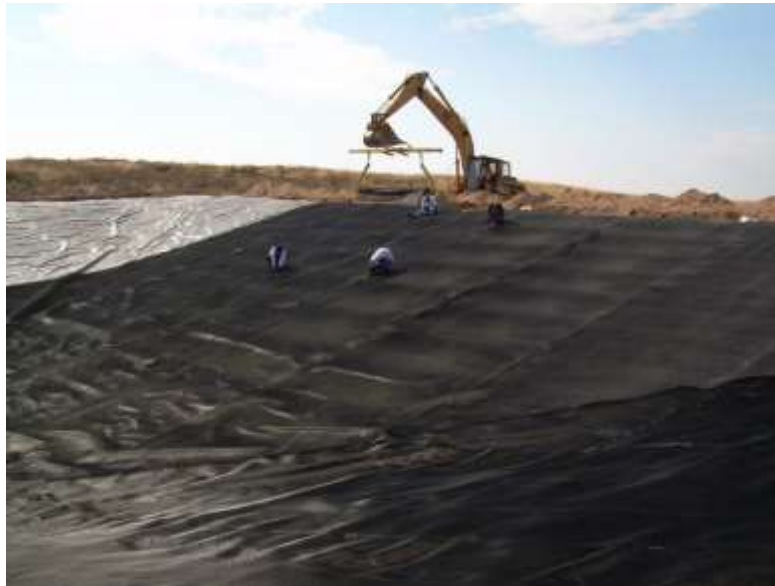
Рисунок 3.5 – Укладка геомембрани HDPE на полігоні ТПВ
